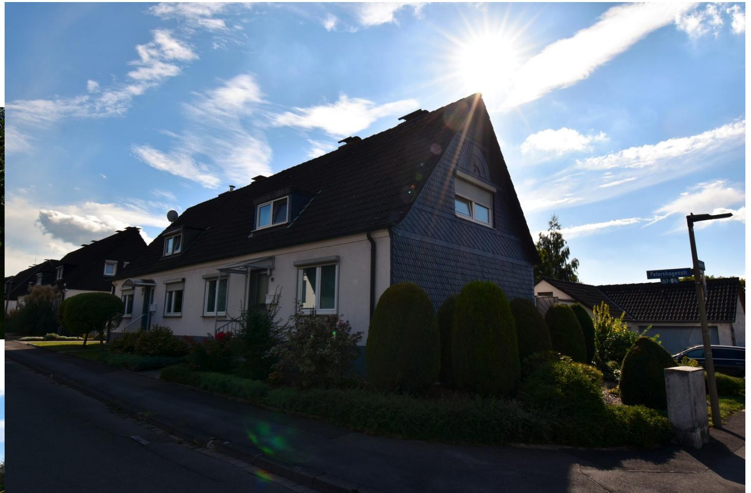
Diese besondere Doppelhaushälfte wurde ursprünglich 1955 erbaut. 1984 wurde das Dach neu gedeckt und gedämmt und die Giebelwand isoliert. 1996 wurde die Isolierung erneuert und die Wand mit Naturschiefer verkleidet. Das Haus ist voll unterkellert und 2 Garagen gehören ebenfalls dazu.
